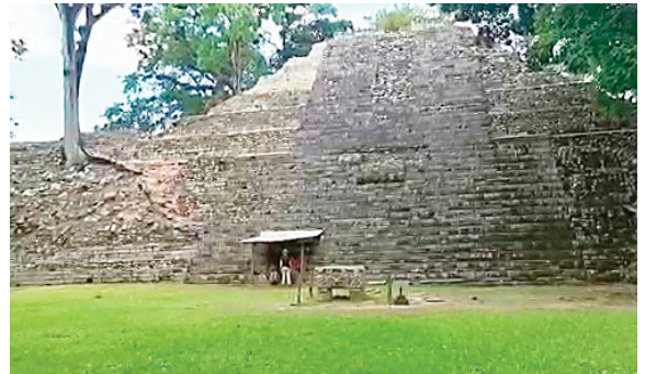
Necesitan entre nueve y diez millones de lempiras para dejar el templo en óptimas condiciones.
