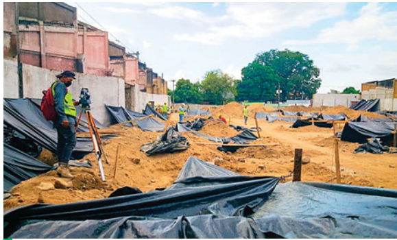
Los colaboradores municipales trabajan en la fundición de concreto para refuerzo de las cimentaciones.
