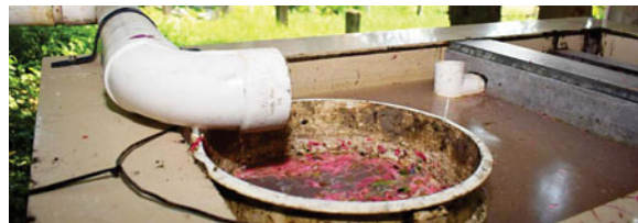
Con este mecanismo, se captura la grasa de los 66 restaurantes. En cada uno hay una pila. Después la grasa se regala a una planta que la convierte en biodiésel.
