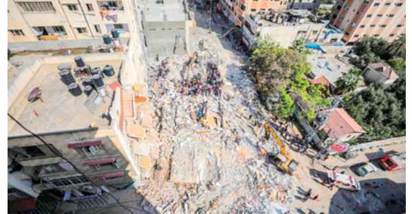
Los bombardeos han destruido 76 edificios, unas 725 viviendas han sufrido daños importantes y otras 4,134 "daños menores".
