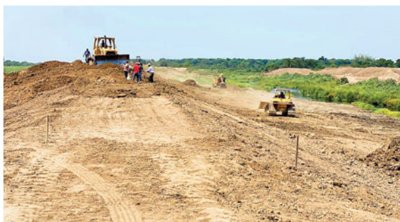
Son 42 millones de lempiras los que se están invirtiendo en reparar los daños del Canal Maya.
