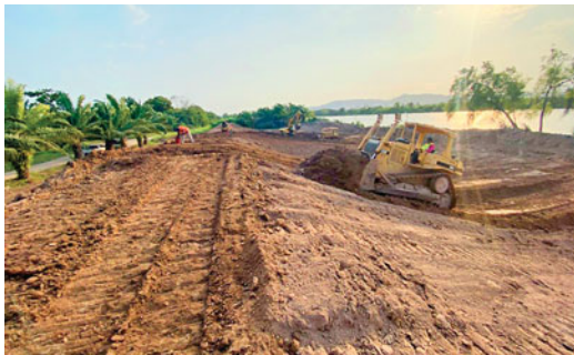
Trabajos en Finca 8 en El Progreso. Actualmente se trabaja en cinco sectores de La Lima, en tres de San Manuel, dos en El Negrito y en El Progreso hay dos lotes de proyectos.
