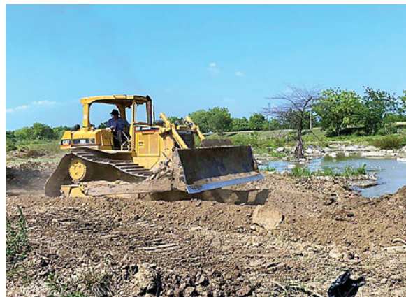
El aeropuerto de San Pedro Sula sufrió innumerables daños al estar bajo las aguas del río Chamelecón y Ulúa.
