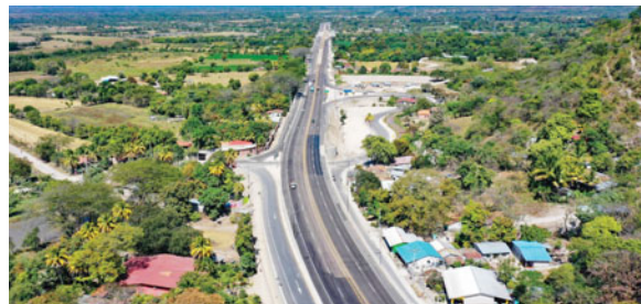
El mandatario hizo un recorrido para ver los avances de la reconstrucción del tramo carretero Talanga-Cedros.
