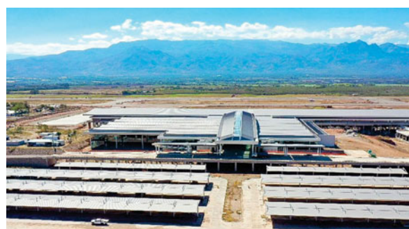
En primer plano los estacionamientos techados, más allá la terminal.
