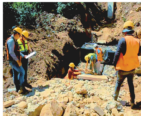
Trabajando en el mantenimiento de las tuberías.
