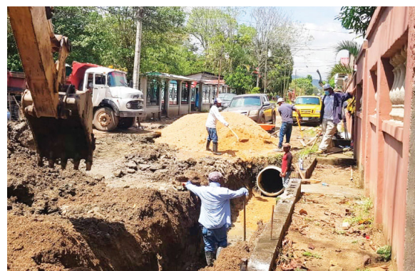
Recientemente se inició con la instalación de tubería de impulsión, la cual beneficiara a los habitantes de la colonia La Unión, del sector Este del municipio.
