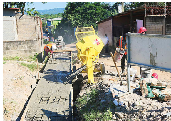
La comunidad de Pueblo Nuevo, junto a la municipalidad construyen una caja de paso, luego que fuera destruido por los huracanes de noviembre 2020.
