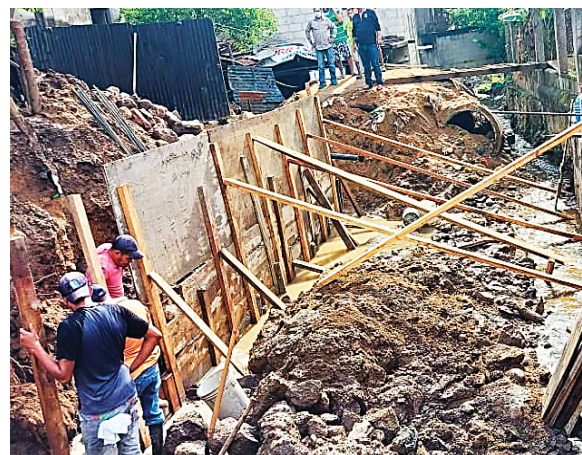
Instalación de colector de aguas lluvias, el cual se ejecutó como parte del presupuesto participativo en el barrio José Cecilio del Valle.
