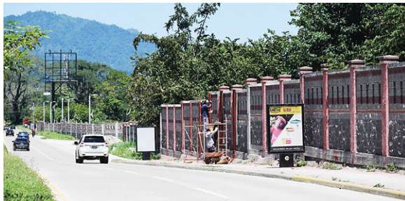
La construcción del muro perimetral dio inicio a mediados del 2017, por diversos factores, hasta el momento no se ha finalizado.
