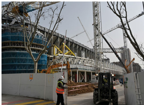
En las afueras se están haciendo trabajos para facilitar la movilidad.
