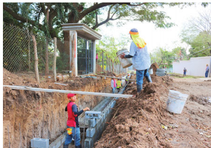
Con miras a una pavimentación a corto o mediano plazo, la municipalidad ejecuta la construcción de cunetas y caja puente frente al instituto Pompilio Ortega.
