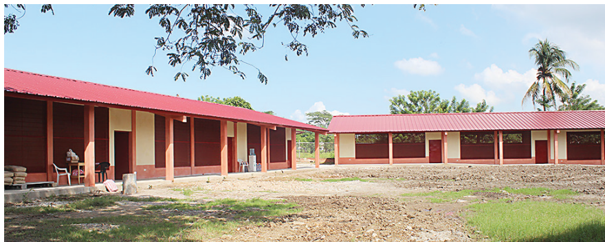
Uno de los proyectos que se desarrolló en el área de educación es la construcción de un centro educativo en la colonia Villa Real, obra que se ejecutó con un fuerza mancomunado.
