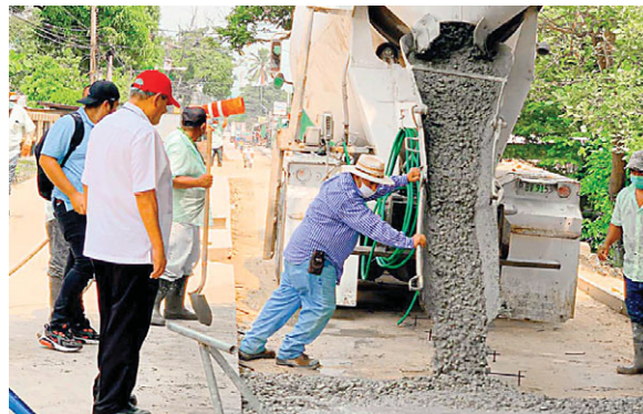
De gorra roja, Crivelli supervisando obras de pavimentación.
