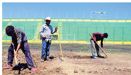
El trabajo de remoción de la gruesa capa de lodo que asfixió la grama se realiza de manera manual.
