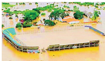
El estadio quedó bajo las aguas debido al desborde del Canal Maya y el río Chamelecón.
