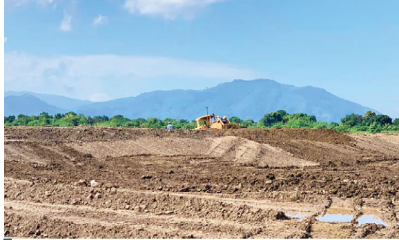
Las obras son ejecutadas bajo la coordinación de la Comisión para el Control de Inundaciones del Valle de Sula.
