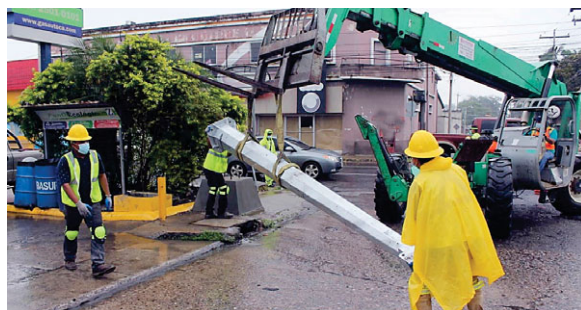
Los equipos municipales están trabajando en la instalación de las bases o estructuras donde se colocarán los semáforos.
