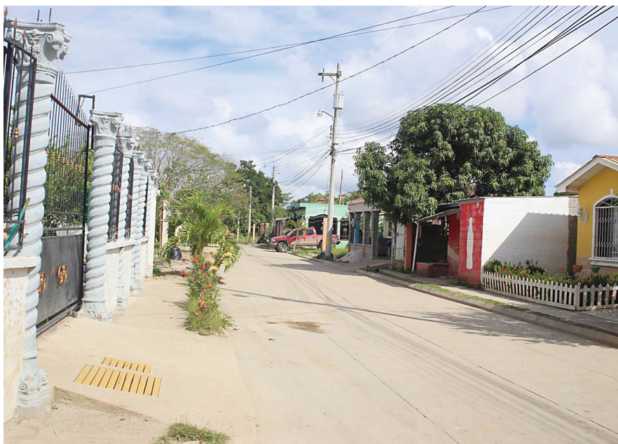
Las calles de la colonia Oro Verde lucen limpias como si no hubieran recibido daños por tormentas, el equipo trabajó sin parar hasta lograr el objetivo.
