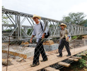
Mientras se habilita el puente Bailey, los pobladores hacen uso de una estructura colgante.
