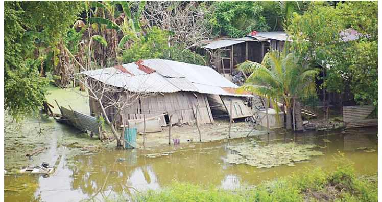
Todavía hay casas que el acceso es aún más difícil por el agua que permanece acumulada.
