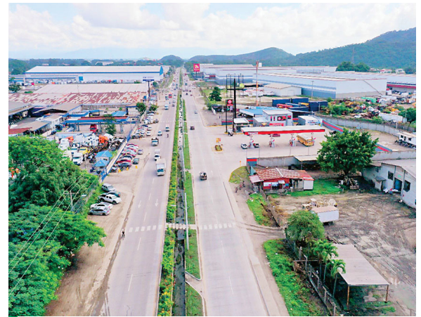
La construcción de estas obras en la 33 calle ha generado la creación de nuevos negocios como son bodegas, maquilas y ferreterías.
