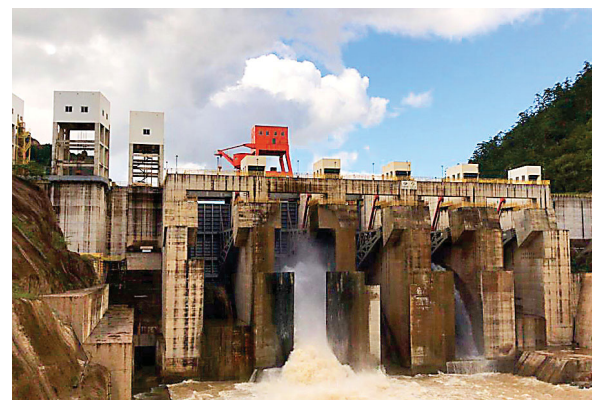
El nivel actual del embalse de la central hidroeléctrica Patuca III es de 289.82 m.s.n.m.
