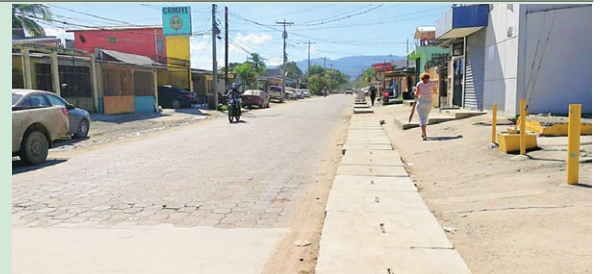
Vecinos de la zona, están satisfechos con la obra, porque ya no tienen problemas de inundaciones.
