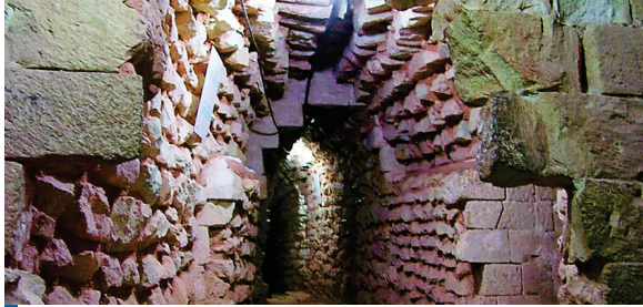
El mandatario Juan Orlando Hernández ordenó la reparación del Templo Rosalila.
