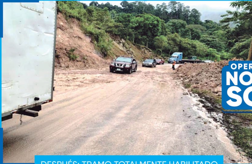
DESPUÉS: TRAMO TOTALMENTE HABILITADO
