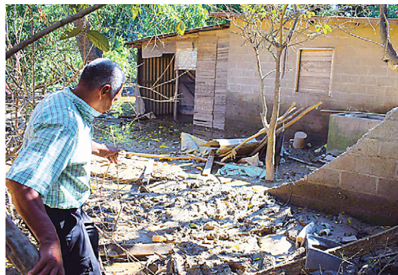
Iriaco Gómez, no solo perdió su inversión en la pulpería, sino que también parte del muro de su casa se cayó.
