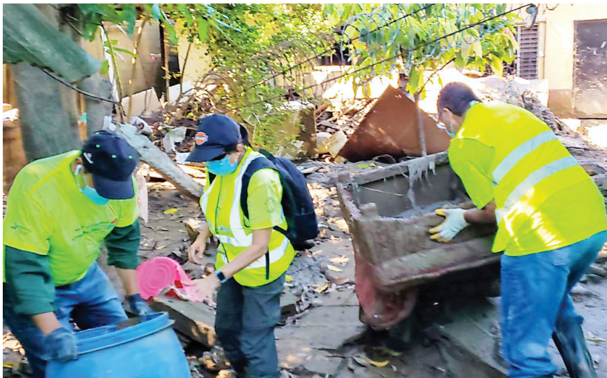
Los colaboradores municipales avanzan con los trabajos de limpieza removiendo escombros y la basura acumula que impide el acceso a las viviendas.
