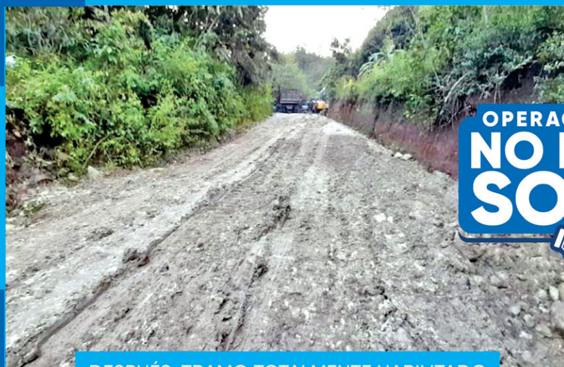
DESPUÉS: TRAMO TOTALMENTE HABILITADO
