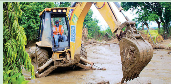
Los equipos operativos de limpieza, distribuidos en las zonas afectadas, cuentan con retroexcavadoras, volquetas, patrones y tractores.
