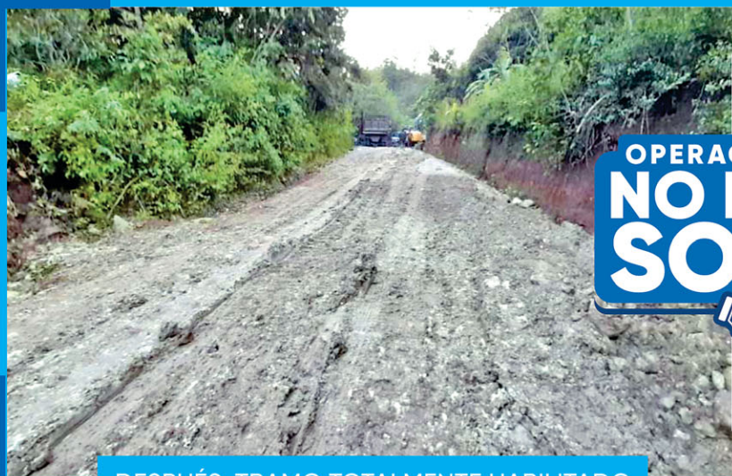
DESPUÉS: TRAMO TOTALMENTE HABILITADO
