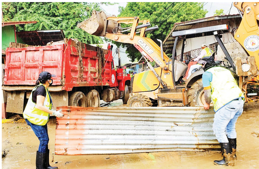
La maquinaria y el personal que labora están quitando la basura y materiales que se desprendieron de las viviendas para dejar libre acceso.
