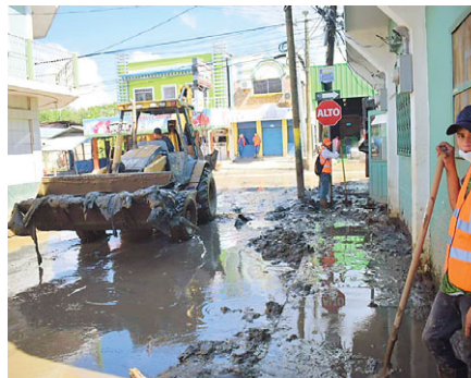
En La Lima también se llevan a cabo los trabajos de limpieza, después de las mejoras que ha tenido el clima ya es factible continuar.
