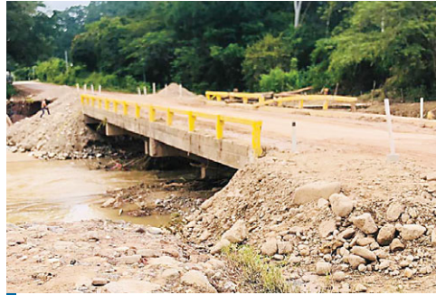
El Puente en Las Malvinas, fue rellenado para habilitar el paso hacia La Entrada, Copán.
