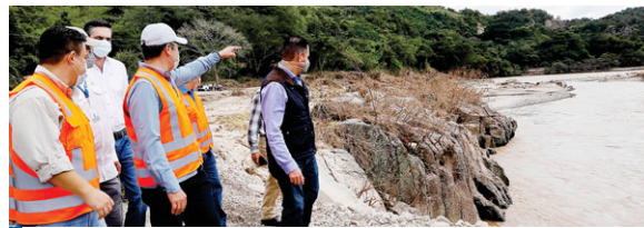
El anuncio lo hizo Hernández mientras supervisaba los trabajos que se realizan en el puente sobre el río Higuito.
