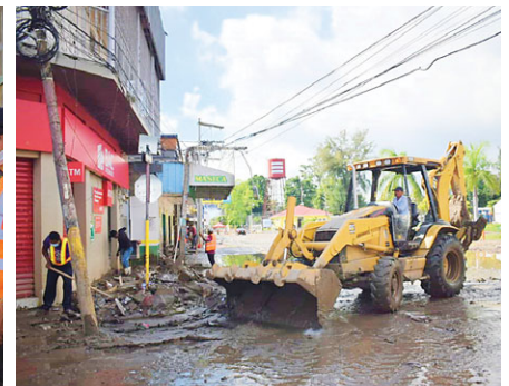
Sacar el lodillo acumulado en las calles es una de las labores más fuertes para los lugareños, con las máquinas se les ha facilitado el trabajo.
