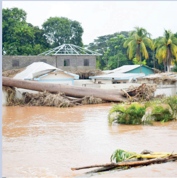
Viviendas y negocios del sector quedaron destruidos debido a la caída de árboles.
