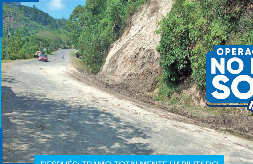
DESPUÉS: TRAMO TOTALMENTE HABILITADO
