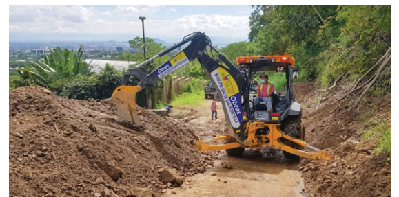
Las maquinarias se mantienen trabajando en la habilitación de las vías obstruidas.
