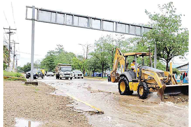
Los trabajos consistieron en despejar vías bastante transitadas como la del Bulevar del Sur.
