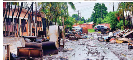
Las colonias Céleo y La Planta también reflejan la destrucción que tuvieron. Hasta ahora permanecen desoladas.
