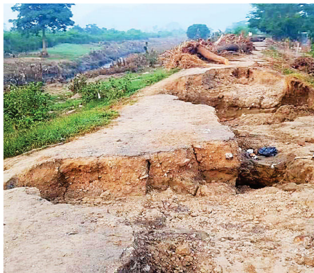
Las imágenes muestran cómo estaba este bordo, aguas arriba del puente Chotepe, y cómo quedó tras recibir una reparación provisional.
