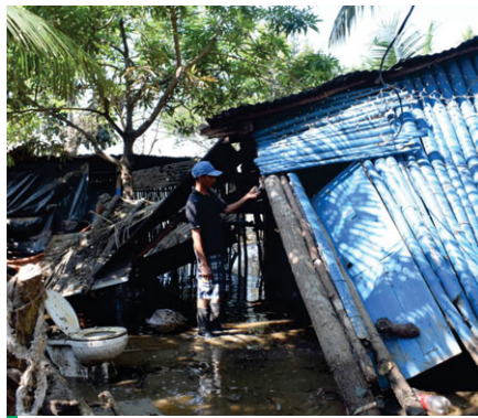
Las pequeñas viviendas construidas de láminas de zinc y algunas de nylon o bajareque quedaron destruidas.
