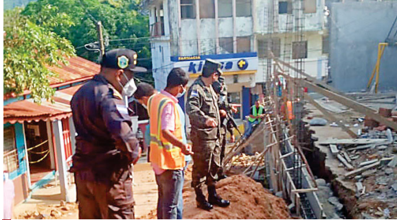
Al actual centro penitenciario se le está reconstruyendo el muro perimetral que colapsó el pasado mes de marzo.
