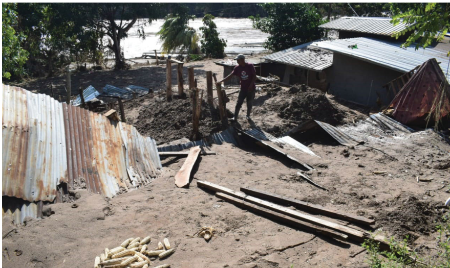
Pedro José Amaya caminaba ayer sobre lo que un día fue su casa y la bodega donde mantenía 60 cargas de maíz que perdió en su totalidad.
