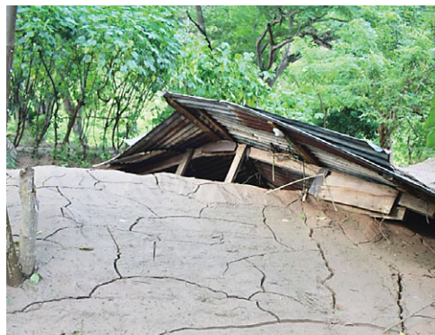
En las viviendas que el agua no arrastró, el lodo llegó hasta el techo, dejándolas inhabitables.
