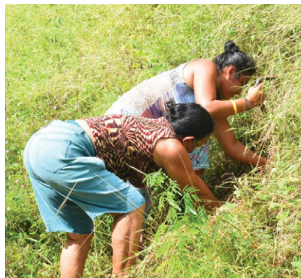
También existen problemas de agua. Aquí dos señoras escarban una tubería intentando obtenerla para sus familias en el albergue.
