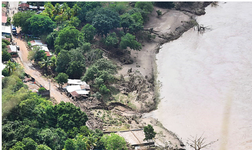
A la derecha, junto al río, se observa la franja de tierra desnuda donde alguna vez estuvo el barrio Abajo. La única casa que quedó en pie fue la de don Antonio Corea.
