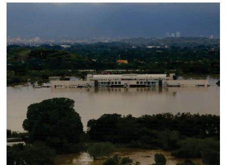
EL aeropuerto Ramón Villeda Morales permanece inundado.
