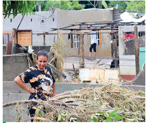
De muchas casas no quedó ni rastro. Otras fueron bastante dañadas.
