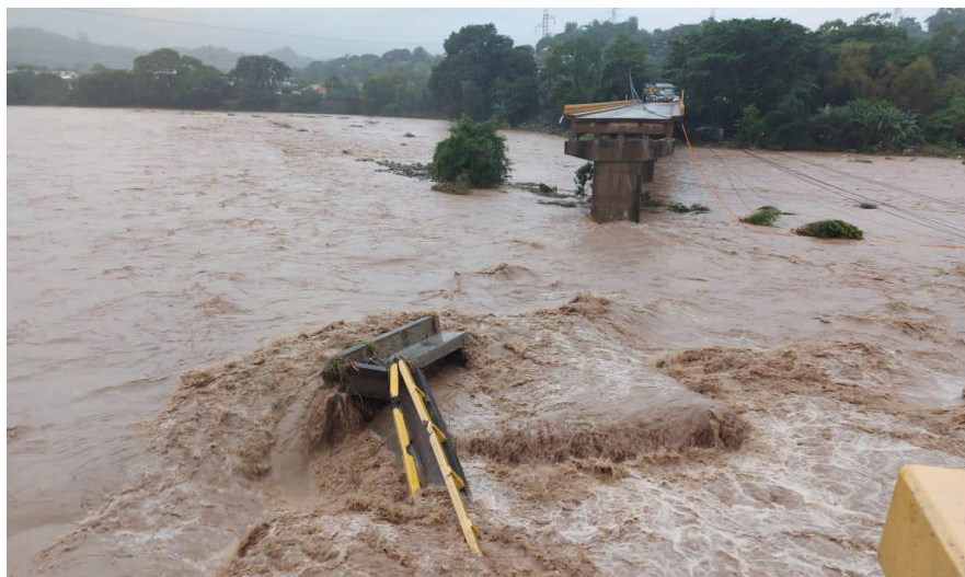
El puente Saopin, sobre el río Cangrejal, fue reconstruido después del huracán Mitch. Esta vez tampoco salió ileso.
