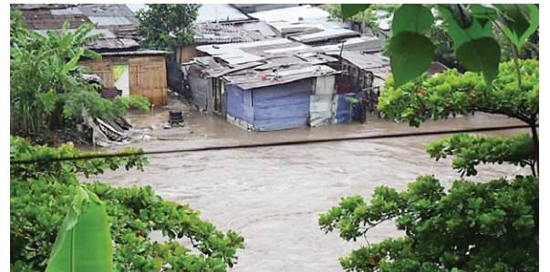
Ayer el caudal del Río Blanco estaba a punto de arrasar algunas casas.
