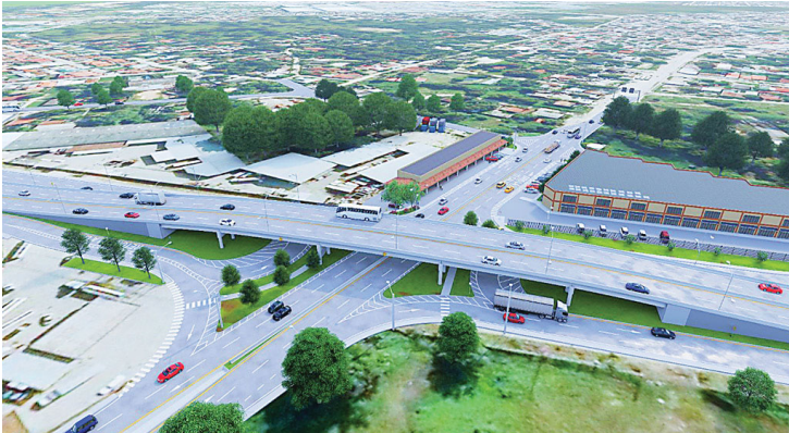
De esta manera quedará la obra ya finalizada, la cual dará una mejor calidad de vida a los sampedranos.
