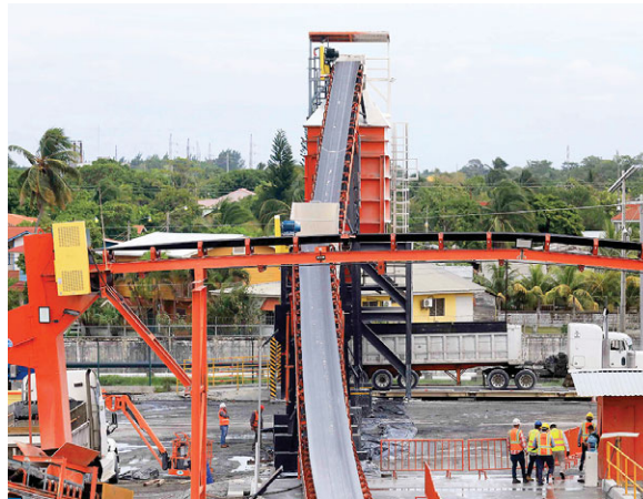
La construcción de la Terminal Muelle 2A se llevó a cabo en un tiempo récord de seis meses.
