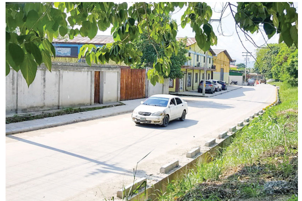
Parte del tramo ya está habilitado. Cientos de sampedranos son beneficiados con esta obra.
