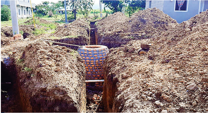
En algunas partes ya se están instalando las tuberías que van hacia las casas.
