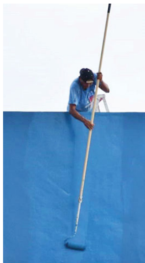
La parte superior del edificio principal ya está siendo pintada.
