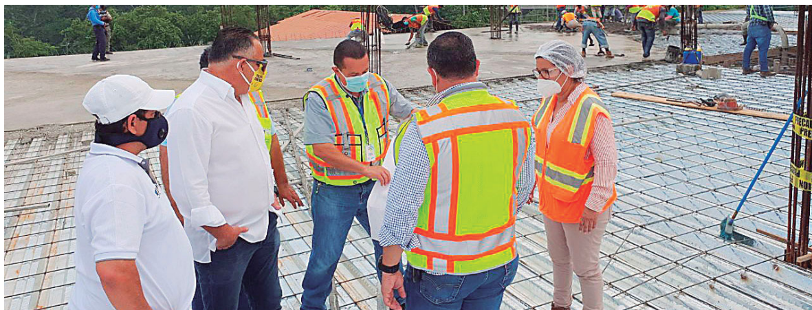
El edil sampedrano realizó la supervisión junto a los encargados de la obra, para cerciorarse del correcto avance de la edificación.
