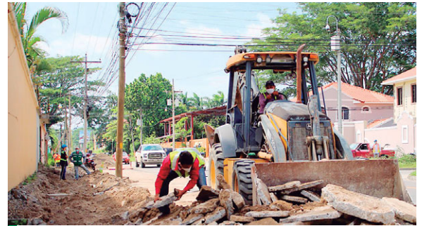
Los equipos municipales trabajan en la construcción de un colector de aguas lluvias cuya longitud es de 800 metros lineales.
