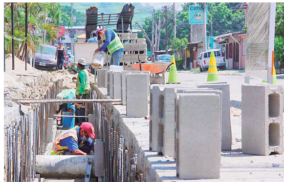
Los colaboradores municipales trabajan con las medidas de precaución en la zona que es muy transitada.
