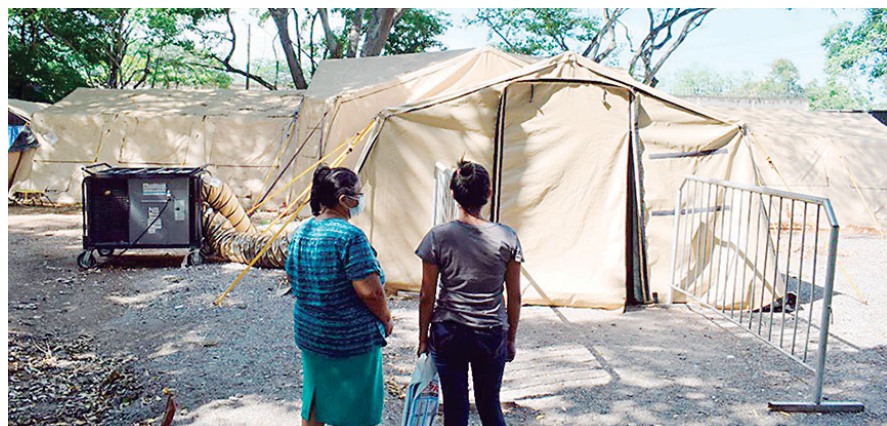
Luego de que se filtrara agua a las carpas, en septiembre el hospital móvil fue movilizado a un área contigua.
